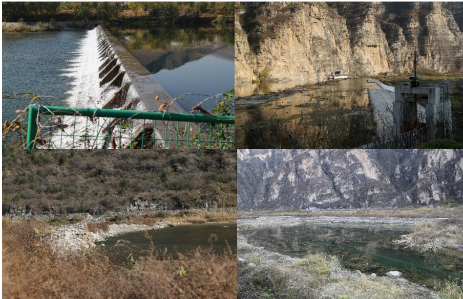
北京市房山拒马河水生野生动物自然保护区内水坝照片
