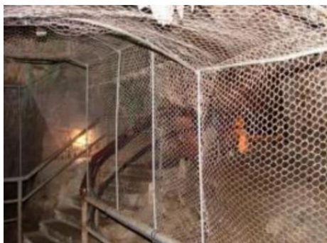
图 2.11 施工前的护网
