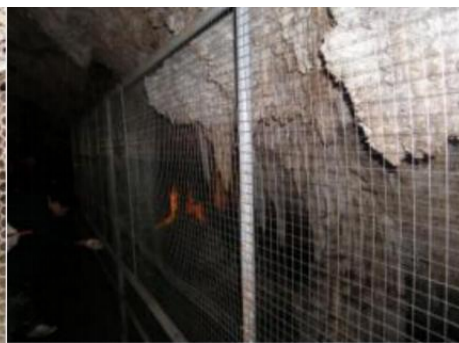
图 2.12 施工后的护网
