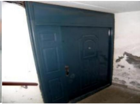
图 2.4 施工后出口防风保温门
