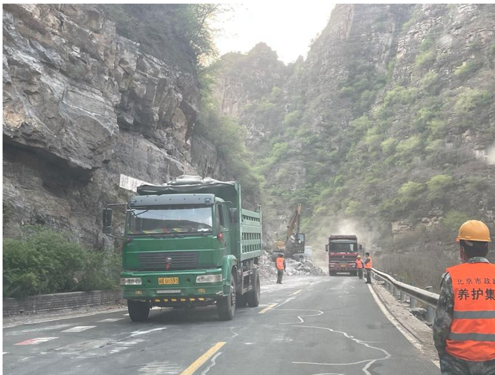
图 4-26 崩塌落石导致道路中断
