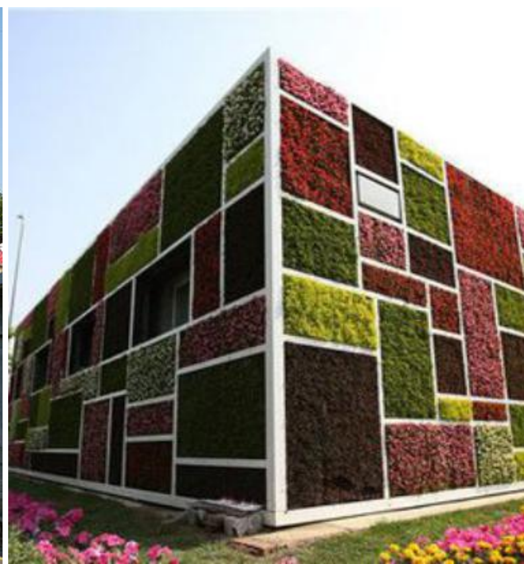
植物水泥防护墙
